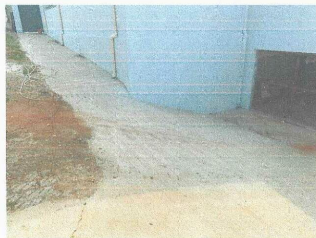
Vista da lateral direita – Execução do piso - 01/10/2025
