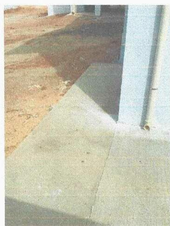
Vista da lateral esquerda – Execução do piso - 01/10/2025
