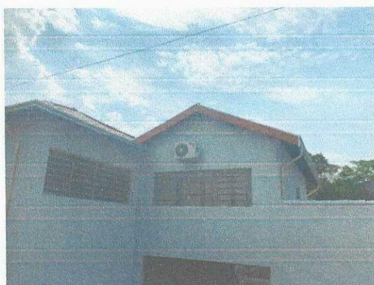
Vista pavimento inferior lateral direita – Execução da pintura e condutores - 01/10/2025
