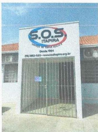
Vista da acesso principal – Instalação da logo da instituição - 01/10/2025
