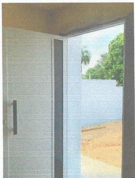
Vista do pavimento inferior interna – Instalação de porta 1 - 01/10/2025
