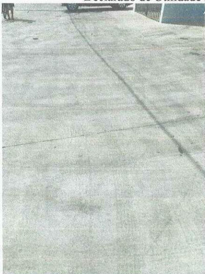
Vista da fachada frontal – Execução do piso - 01/10/2025
