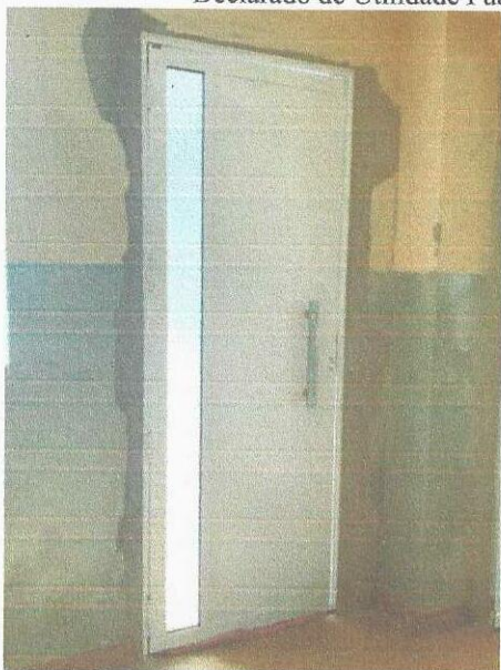
Vista do pavimento inferior interna – Instalação de porta 2 - 01/10/2025
