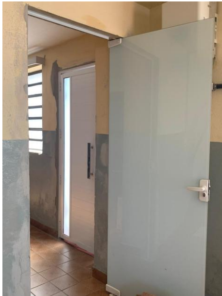
Vista do pavimento inferior interna – Instalação de porta 3 - 01/10/2025
