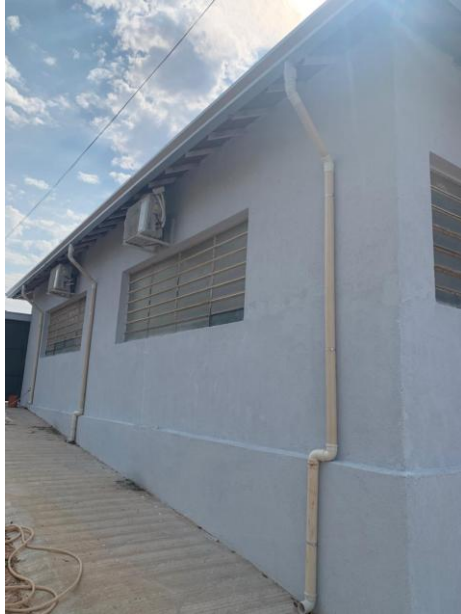
Vista lateral direita – Execução da pintura e condutores - 01/10/2025
