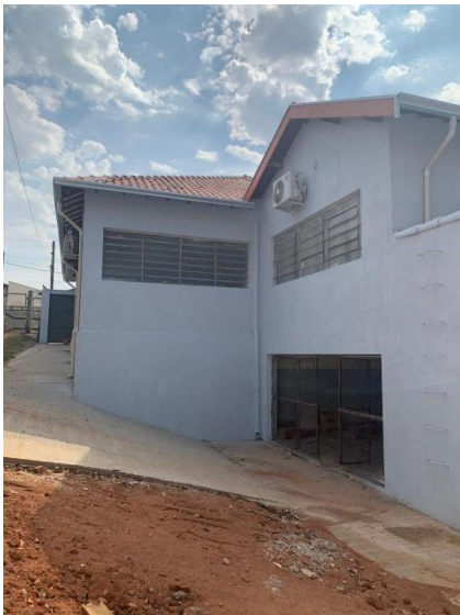
Vista pavimento inferior lateral direita – Execução da pintura e condutores - 01/10/2025
