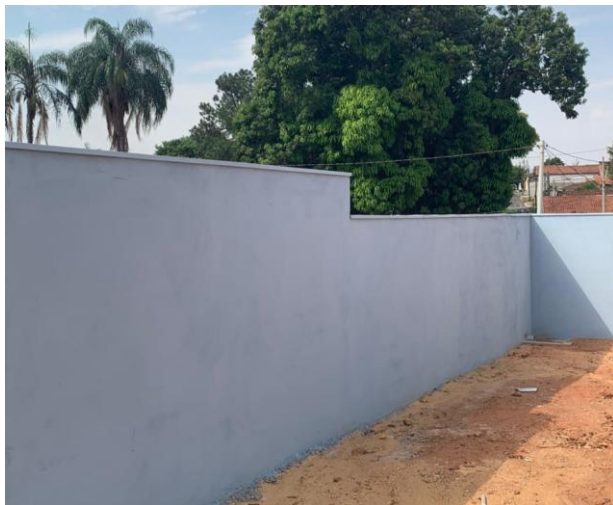
Vista pavimento inferior – Execução do muro e rufo - 01/10/2025
