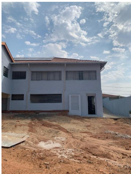
Vista pavimento inferior – Demolição de cobertura, parede e piso em mal estado e execução de pintura, esquadria, tabeira, calha, condutor, rufo e forro - 01/10/2025
