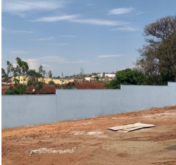
Vista pavimento inferior – Execução do muro e rufo - 01/10/2025
