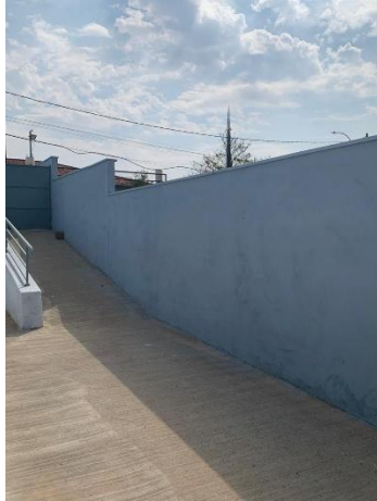
Vista da lateral esquerda – Execução do muro e piso - 01/10/2025
