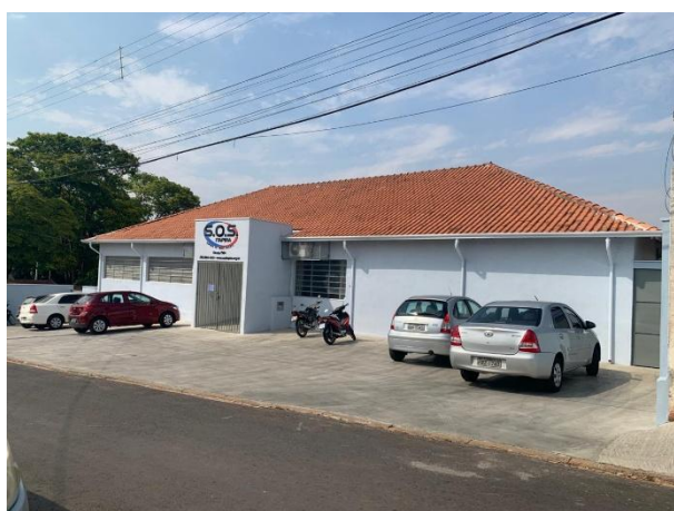
Vista da fachada frontal – Demolição de cobertura, piso e fechamento em mal estado e execução de piso, parede, esquadria, calha, condutor, rufo e forro - 01/10/2025
