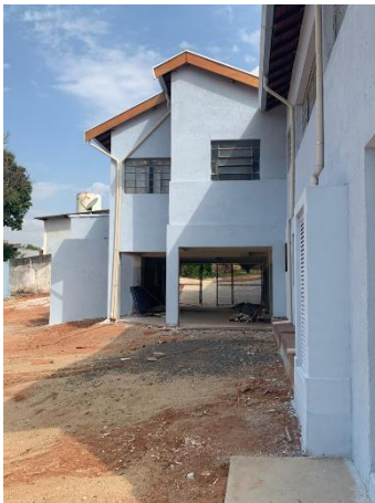
Vista pavimento inferior – Execução da pintura e condutores - 01/10/2025
