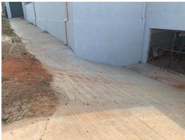
Vista da lateral direita – Execução do piso - 01/10/2025
