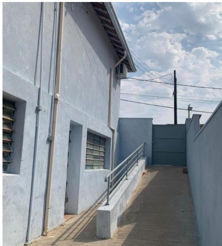
Vista da lateral esquerda – Execução do piso, corrimão, muro, rufo, calha, condutor, forro e esquadria - 01/10/2025
