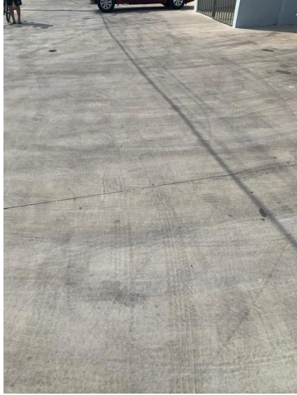
Vista da fachada frontal – Execução do piso - 01/10/2025
