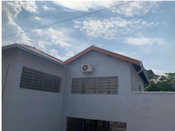
Vista pavimento inferior lateral direita – Execução da pintura e condutores - 01/10/2025
