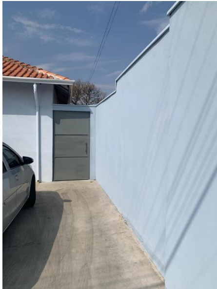
Vista da fachada frontal lateral direita – Execução do muro e portão - 01/10/2025
