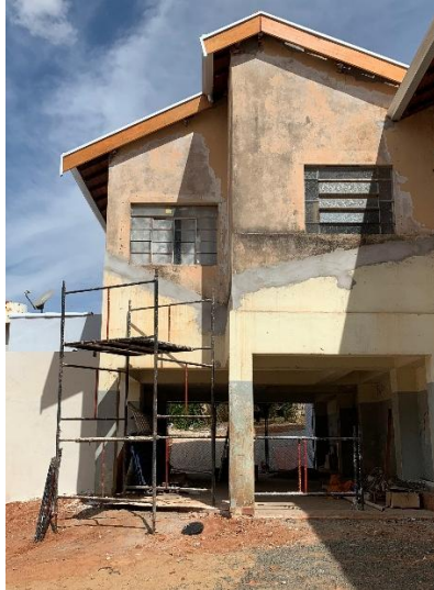
Vista pavimento inferior – Preparação de equipamento para pintura - 31/08/2025
