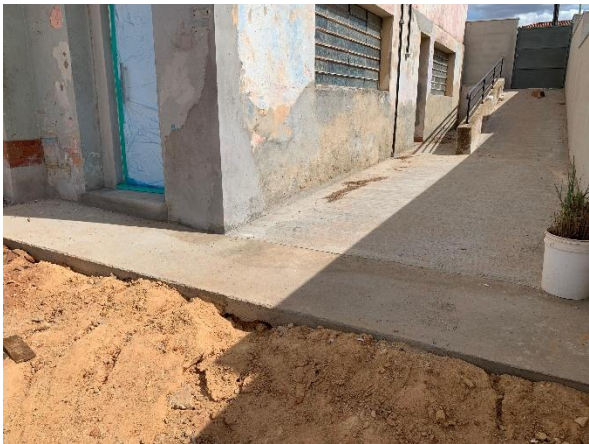
Vista da lateral esquerda – Construção do piso - 31/08/2025
