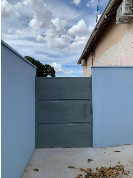
Vista da fachada frontal lateral esquerda – Pintura do portão - 31/08/2025
