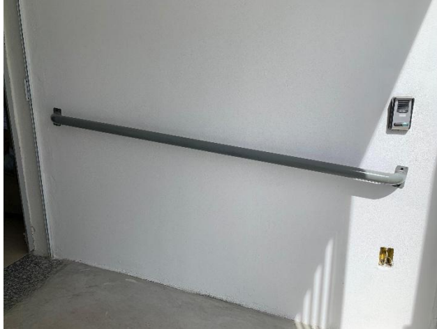
Vista do acesso principal – Instalação do corrimão - 31/08/2025
