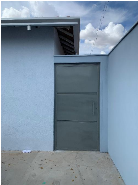
Vista da fachada frontal lateral direita – Pintura do portão - 31/08/2025
