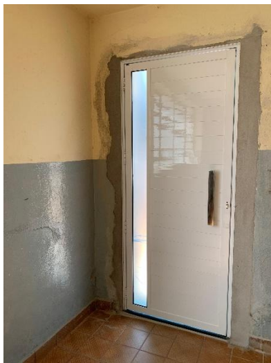
Vista do pavimento inferior interna – Instalação de porta 1 - 31/08/2025
