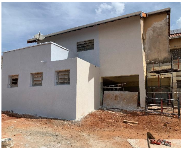
Vista pavimento inferior – Execução do granfino e início da pintura - 31/08/2025
