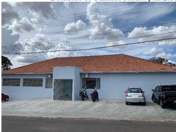
Vista da fachada frontal – Pintura de paredes - 31/08/2025
