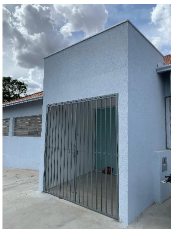
Vista da fachada frontal – Pintura de paredes e esquadrias - 31/08/2025
