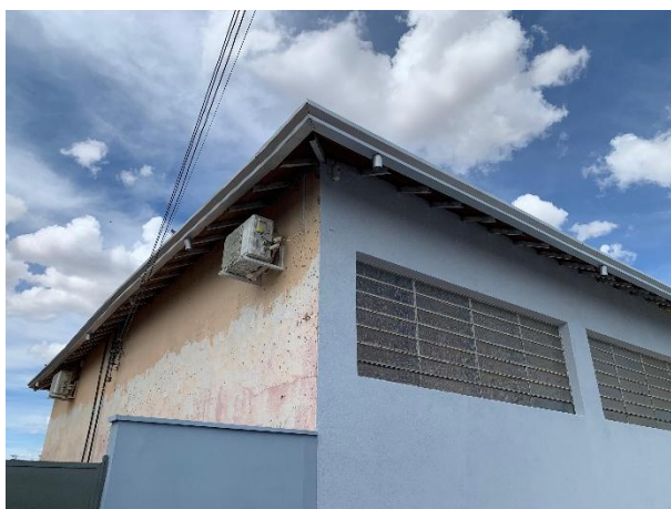
Vista da fachada frontal e lateral esquerda – Início da pintura - 31/08/2025
