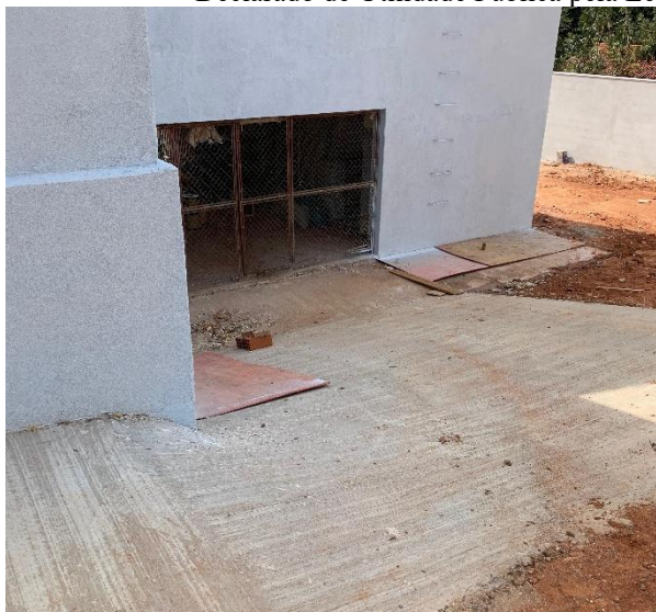
Vista da lateral direita – Construção do piso - 31/08/2025
