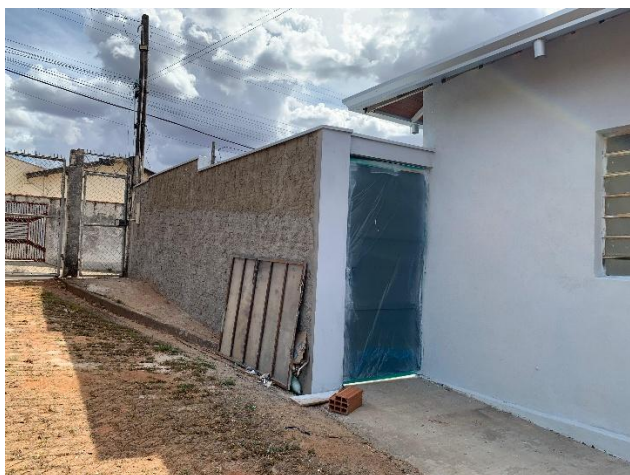
Vista do muro lateral direita – Execução do chapisco - 31/08/2025
