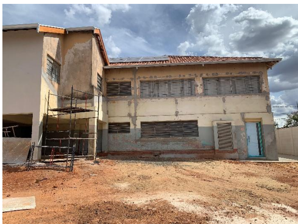
Vista pavimento inferior – Preparação para pintura - 31/08/2025
