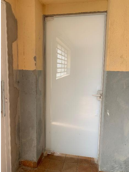
Vista do pavimento inferior interna – Instalação de porta 3 - 31/08/2025
