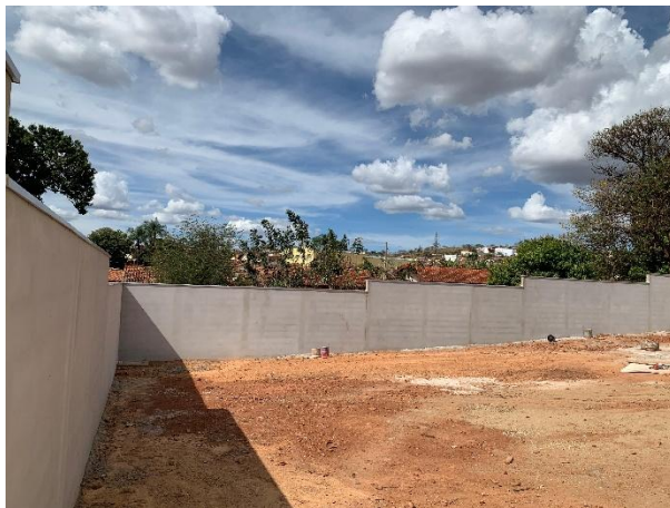
Vista pavimento inferior – Construção dos rufos - 31/08/2025
