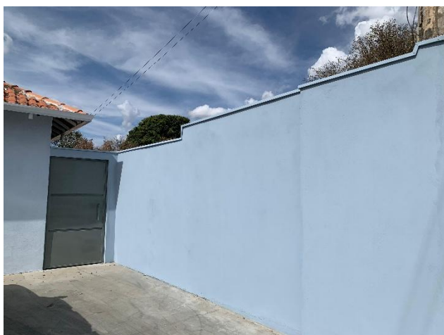
Vista da fachada frontal direita – Instalação de rufo e pintura de paredes - 31/08/2025
