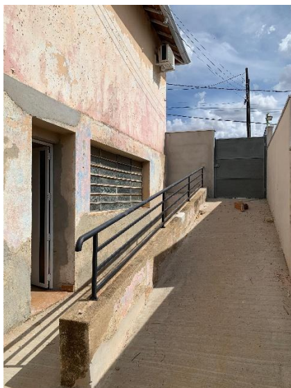
Vista pavimento inferior lateral esquerda – Construção do piso e do corrimão - 31/08/2025
