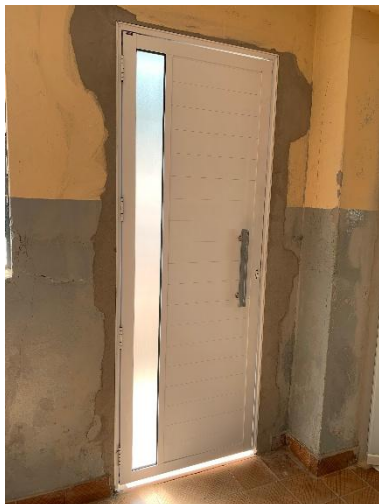
Vista do pavimento inferior interna – Instalação de porta 2 - 31/08/2025
