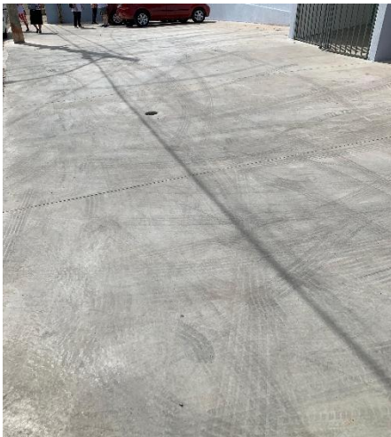
Vista da fachada frontal – Construção do piso - 31/08/2025
