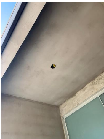
Vista do acesso principal – Construção da cobertura - 31/07/2025
