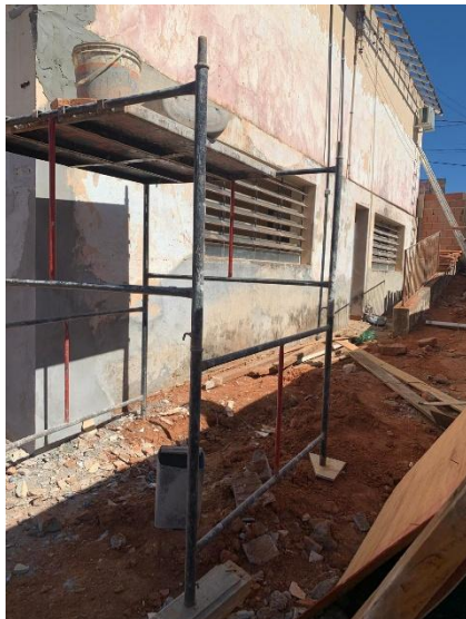
Vista da lateral esquerda – Remoção do piso - 31/07/2025
