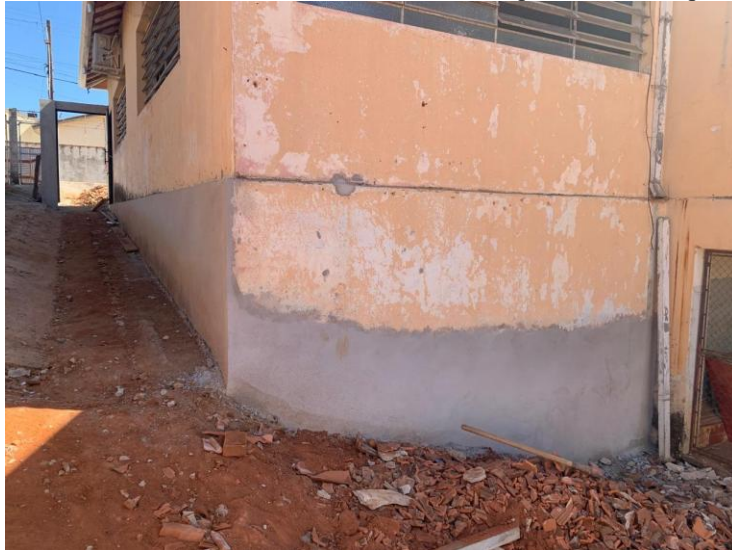
Vista pavimento inferior lateral direita – Reparo nas paredes - 31/07/2025
