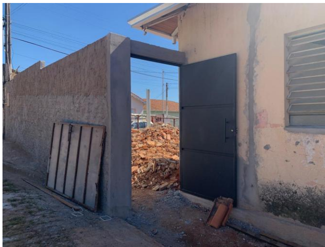
Vista da lateral direita – Instalação de portão - 31/07/2025
