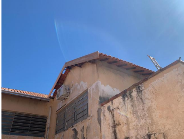
Vista da cobertura posterior lateral direita – Troca de cobertura e instalação de tabeiras e forros - 31/07/2025
