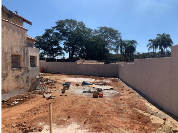
Vista pavimento inferior – Reboco dos muros - 31/07/2025
