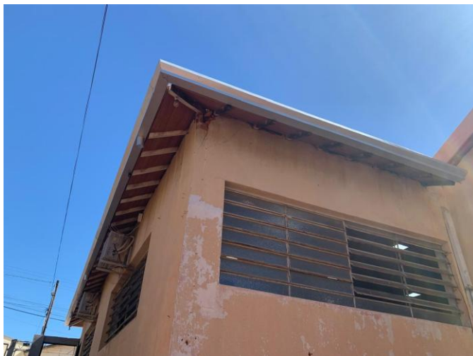
Vista da cobertura da lateral direita – Instalação de calhas e forros - 31/07/2025
