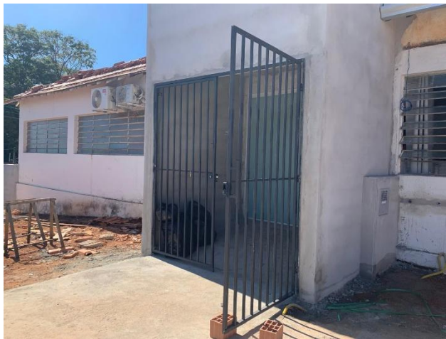
Vista do acesso principal – Instalação do portão - 31/07/2025
