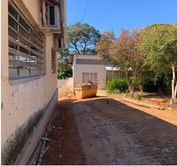
Vista da lateral direita – Demolição do muro - 31/07/2025
