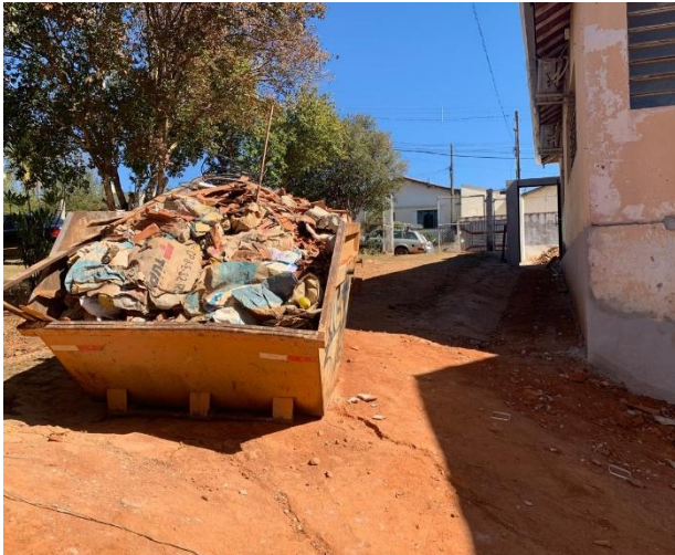
Vista da lateral direita – Remoção do entulho - 31/07/2025
