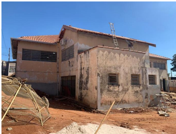
Vista pavimento inferior lateral direita – Limpeza e reparo das paredes - 31/07/2025
