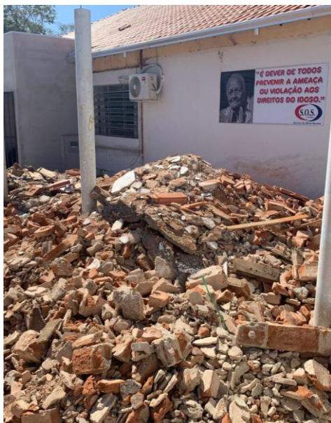
Vista da fachada lateral direita – Demolição do piso - 31/07/2025
