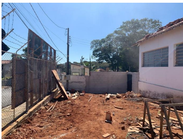
Vista da fachada lateral esquerda – Demolição e retirada do piso - 31/07/2025
