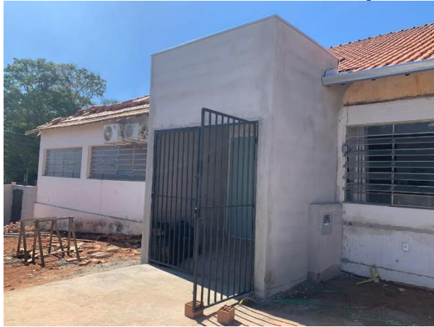
Vista do acesso principal – Construção das paredes de alvenaria - 31/07/2025
