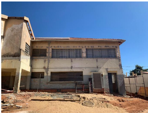
Vista pavimento inferior lateral esquerda – Limpeza e reparo das paredes - 31/07/2025
