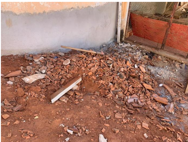
Vista da lateral direita – Demolição da cobertura posterior - 31/07/2025
