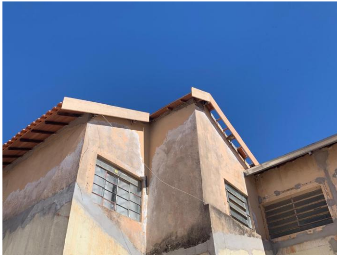
Vista da cobertura posterior lateral esquerda – Troca de cobertura e instalação de tabeiras e forros - 31/07/2025
