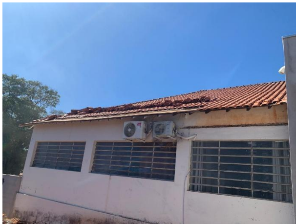
Vista da fachada frontal – Preparo do beirão para instalação de calha - 31/07/2025
