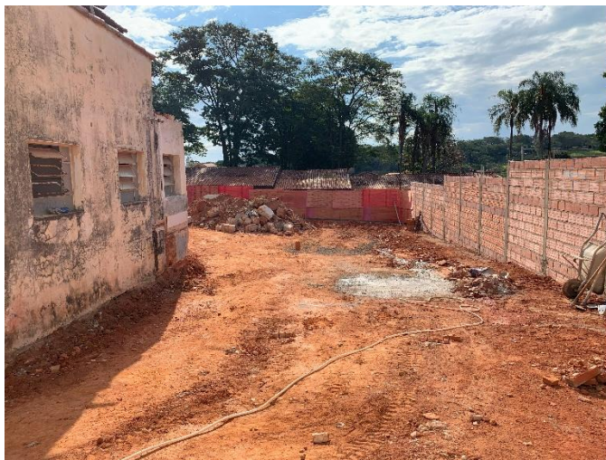
Vista pavimento inferior – Remoção da pavimentação deteriorada - 30/06/2025
