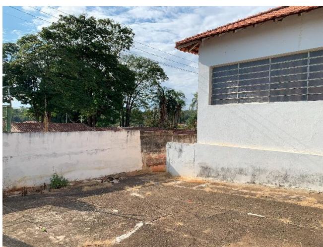
Vista da fachada frontal – Acesso lateral esquerda - 30/06/2025
