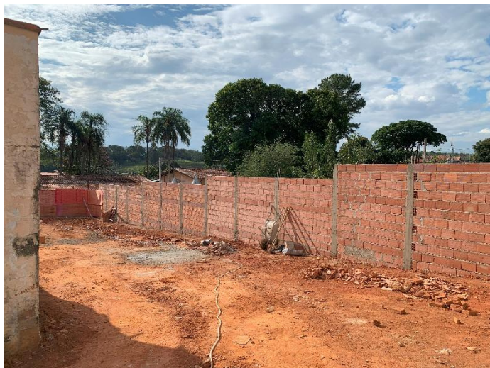
Vista pavimento inferior – Construção de muro posterior - 30/06/2025
