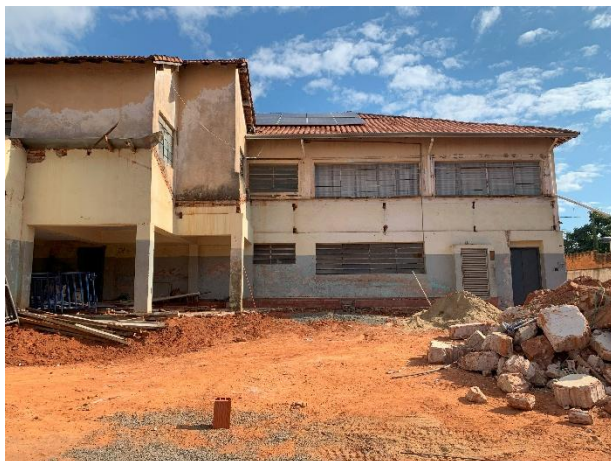
Vista fachada posterior – Remoção da edificação deteriorada - 30/06/2025
