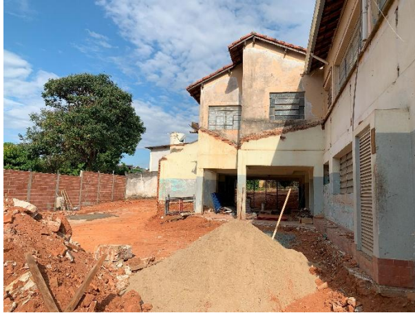
Vista pavimento inferior – Armazenamento de material - 30/06/2025
