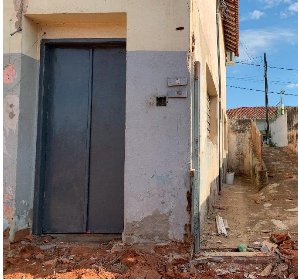
Vista pavimento inferior – Acesso ao pavimento inferior interno - 30/06/2025
