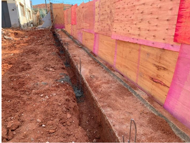
Vista pavimento inferior – Enchimento da fundação dos muros - 30/06/2025
