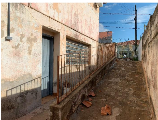
Vista da fachada lateral esquerda – Acesso ao pavimento inferior - 30/06/2025
