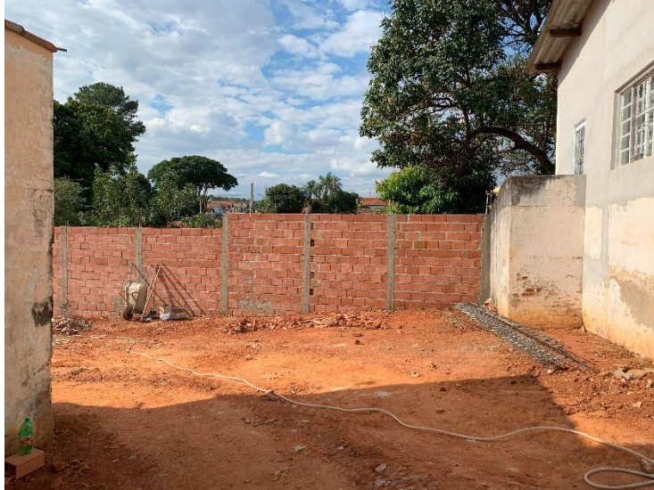
Vista pavimento inferior – Início da construção do muro posterior - 30/06/2025
