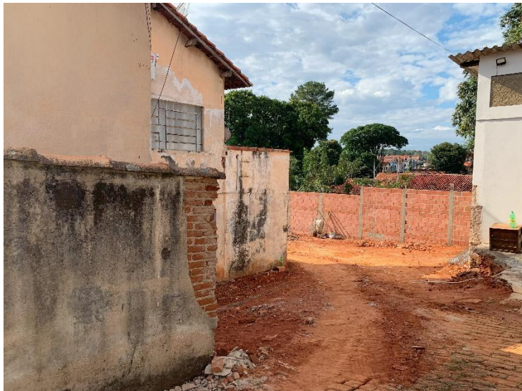
Vista da fachada lateral direita – Acesso de maquinário ao pavimento inferior - 30/06/2025
