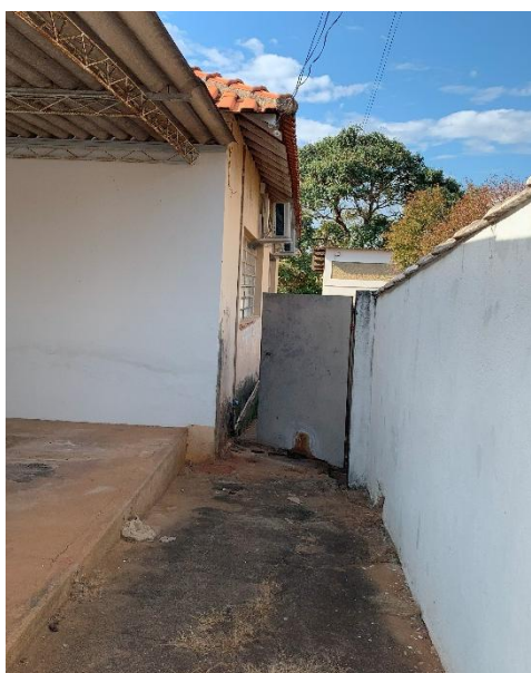
Vista da fachada frontal – Acesso lateral direita - 30/06/2025
