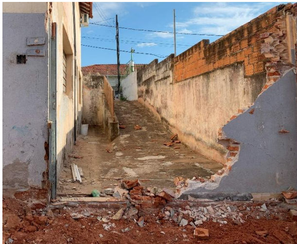
Vista pavimento inferior – Acesso ao pavimento inferior externo - 30/06/2025
