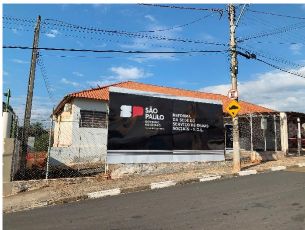
Vista da fachada frontal – Fachada frontal com a placa de identificação - 30/06/2025
