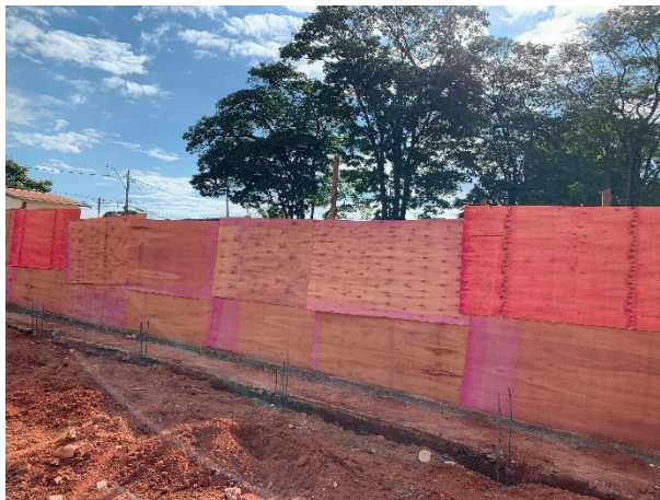
Vista pavimento inferior – Fechamento da divisa com tapume - 30/06/2025
