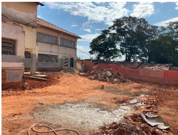
Vista pavimento inferior – Limpeza parcial do entulho - 30/06/2025
